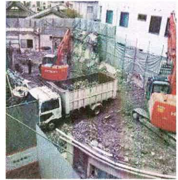
建物部分の解体完了
